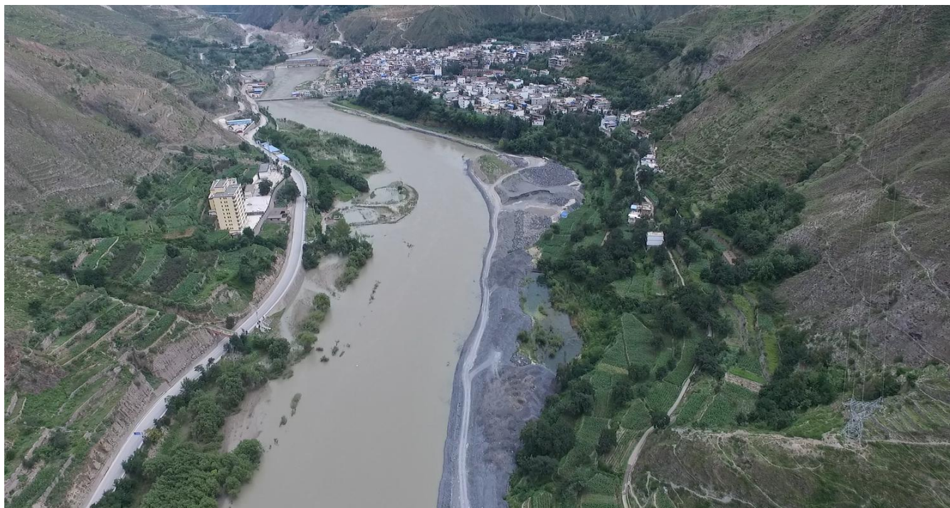
（舟曲县白龙江，废渣堆积侵占河道）
